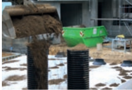
Funzione della copertura temporanea durante il riempimento
