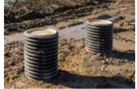
Copertura temporanea dei tubi di prolunga
